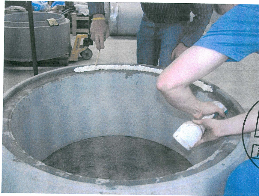
Bild 1: Vorbereitung des Schachtringes durch Befeuchtung und Auftrag des Soudal Brunnen- und Schachtringschaumes
